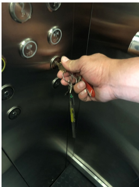
ตำแหน่ง เปิด – ปิด ระบบลิฟต์ภายในตู้โดยสาร
